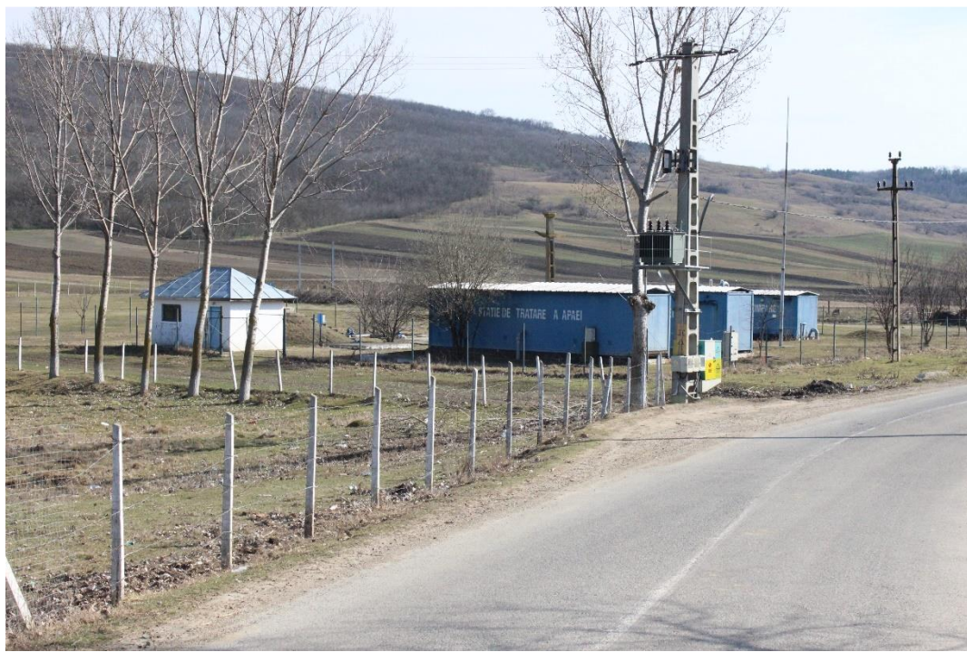
Stație de tratare a apei - comuna Vutcani
